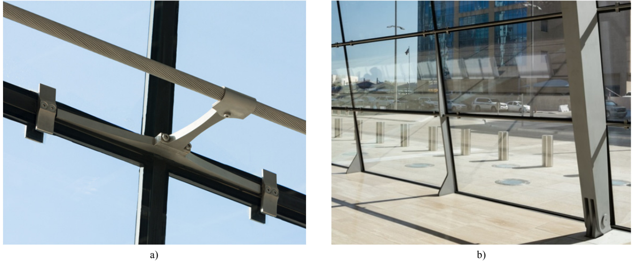
Fig. 4a) View of the façade cable clamps (HG Esch) 4b) View of the base details (HG Esch)
